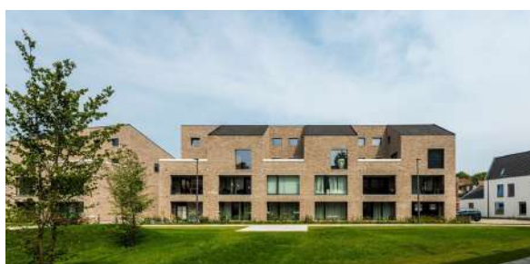
De Indruk, Brugge, Cameleon architects
